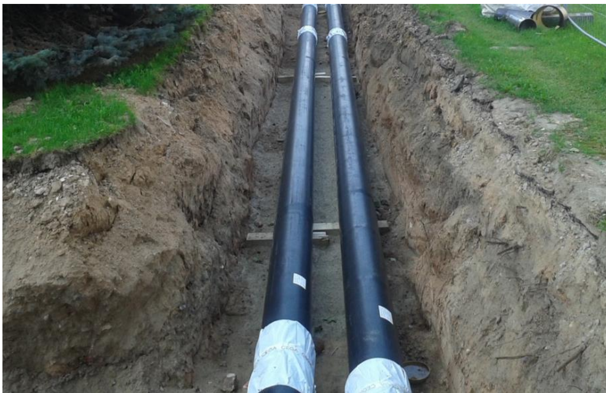
5 pav. Šilumos tiekimo bekanalio vamzdyno klojimas tranšėjoje pavyzdys. Šaltinis: jp.lt
