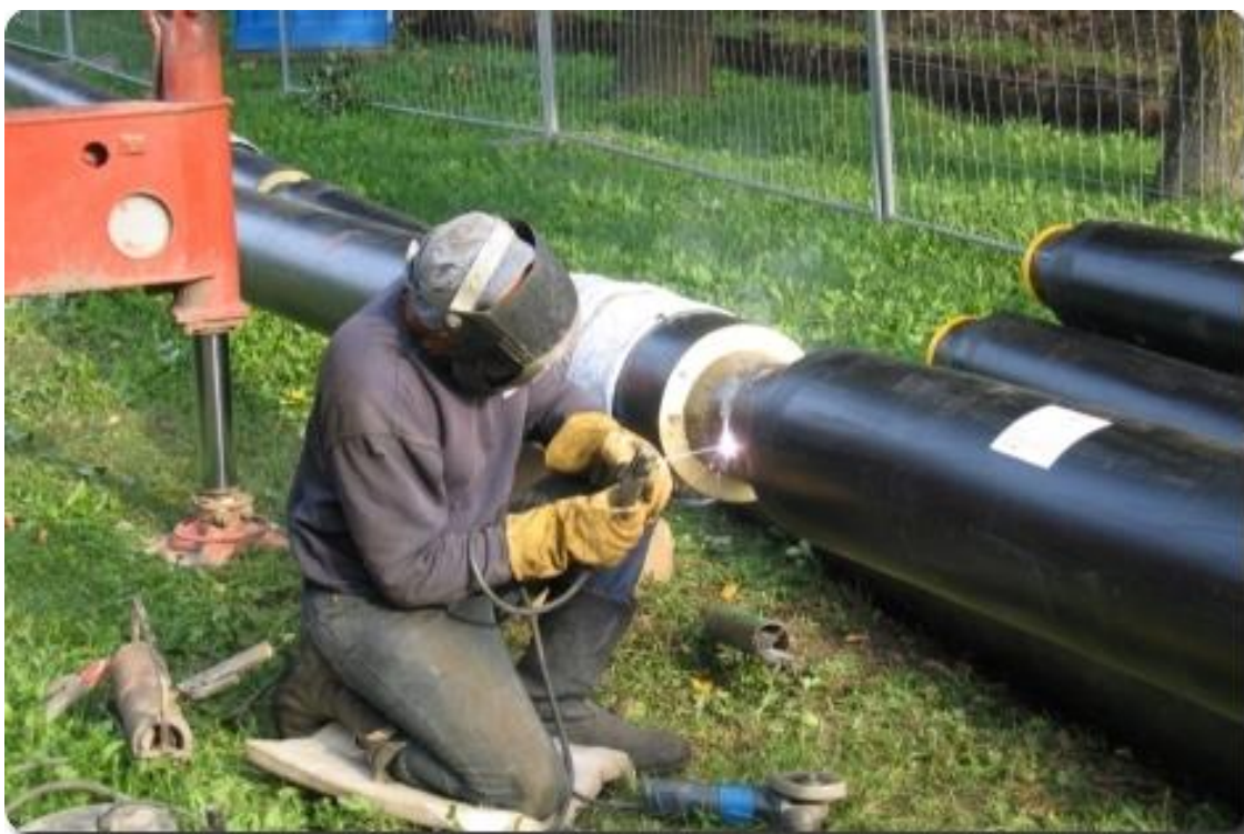
2 pav. Šilumos tiekimo vamzdžių suvirinimas. Šaltinis: dev.klenergija.lt
